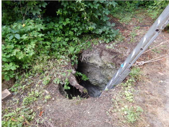
Figure 21 : Effondrement localisé ayant débouché au jour sous forme de fontis
