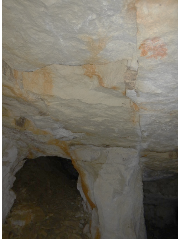
Figure 7 : Dégradations au toit de la carrière du Grenadier français
