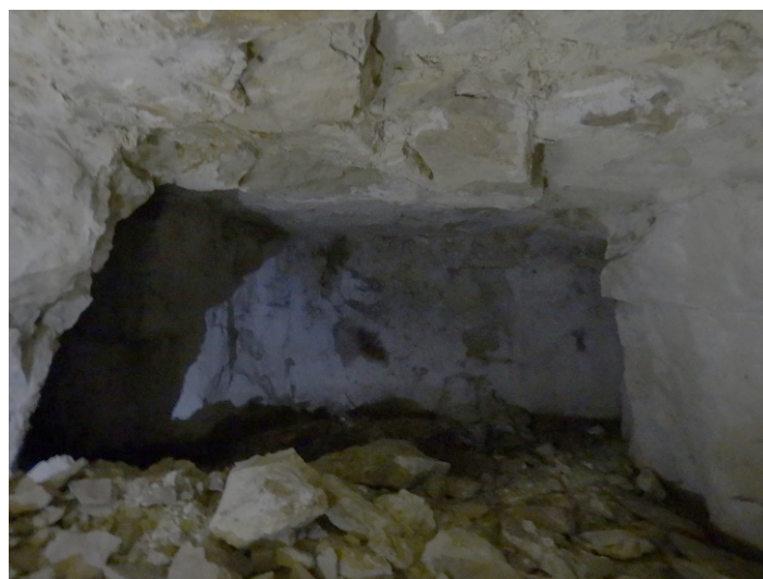
Figure 4 : Vue de l'intérieur de la carrière du Grenadier français et toit dégradé
