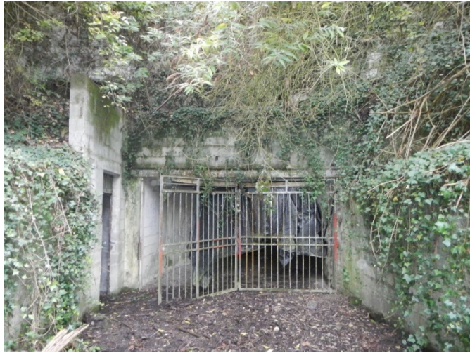
Figure 16 : Entrée en cavage (source : Ineris)
