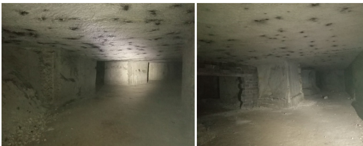
Figure 10 : Vue de l'intérieur de la grande carrière des Richarderies
