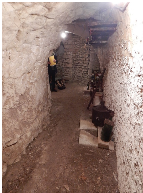
Figure 20 : Exemple d'une cavité d'extension limitée (source : Ineris)
