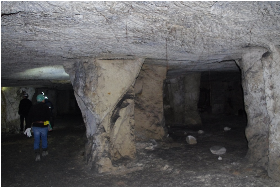
Figure 17 : Exemple d'exploitation par chambres et piliers abandonnés (source : Ineris)
