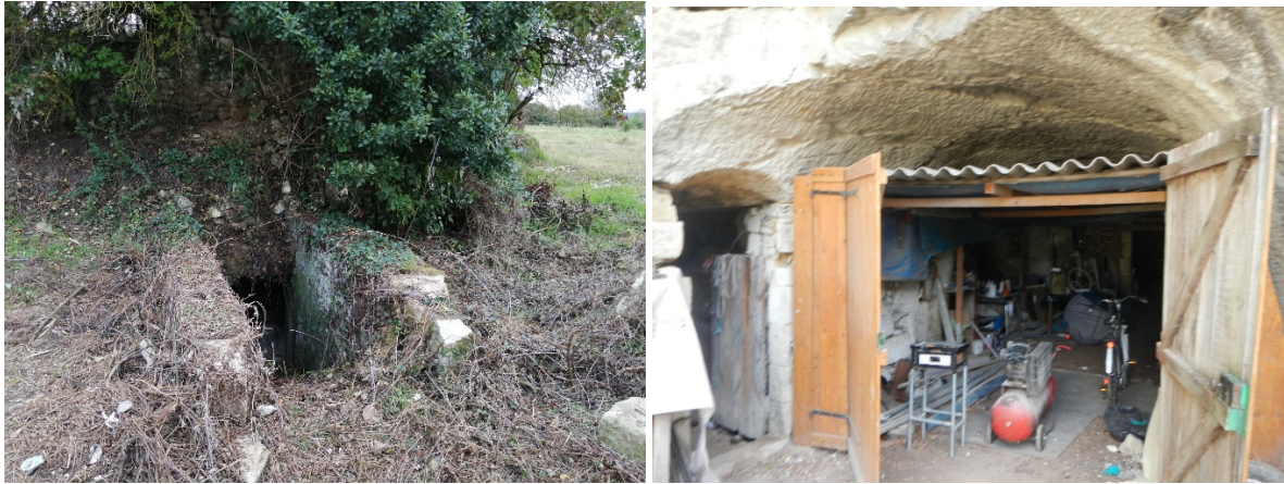
Figure 19 : Les accès aux cavités d'extension limitée (source : Ineris)
