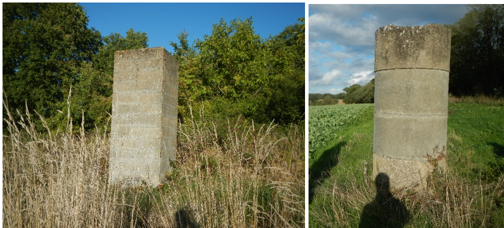
Figure 18 : Photos de cheminées d'aération (source : Ineris)
